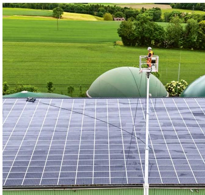
Afin de garantir un rendement optimal des installations solaires du site d'Ecorecyclage SA à Lavigny, les équipes de NovoEnergies SA sont intervenues dans le nettoyage professionnel des 6'000 m<sup>2</sup> de toitures photovoltaïques.
