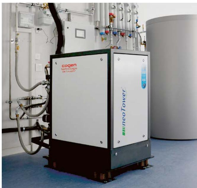
Une unité de cogénération (CCF) produit simultanément de l'électricité et de la chaleur destinée au chauffage et à l'eau chaude sanitaire. Alimentée en biogaz, cette installation permet une production d'énergie entièrement renouvelable.
