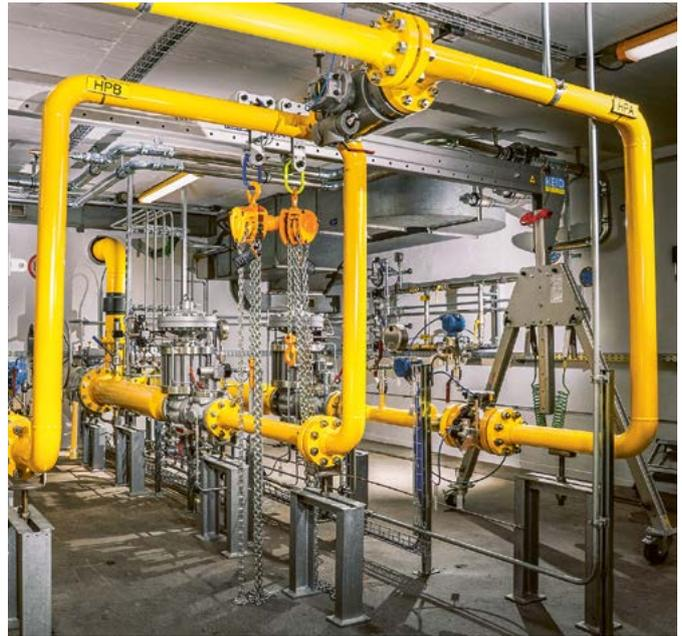
Le poste de détente et de comptage de gaz (PDC) de Gaznat SA à Vevey, qui permet de réduire la pression du gaz livré à la clientèle, a été entièrement rénové durant l'exercice.
