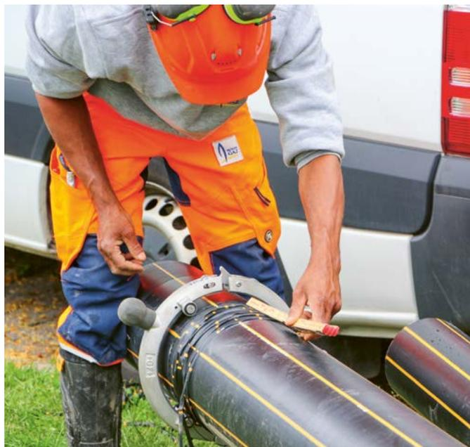
Préparation des conduites avant soudure pour un assainissement sur le réseau de la CICG.
