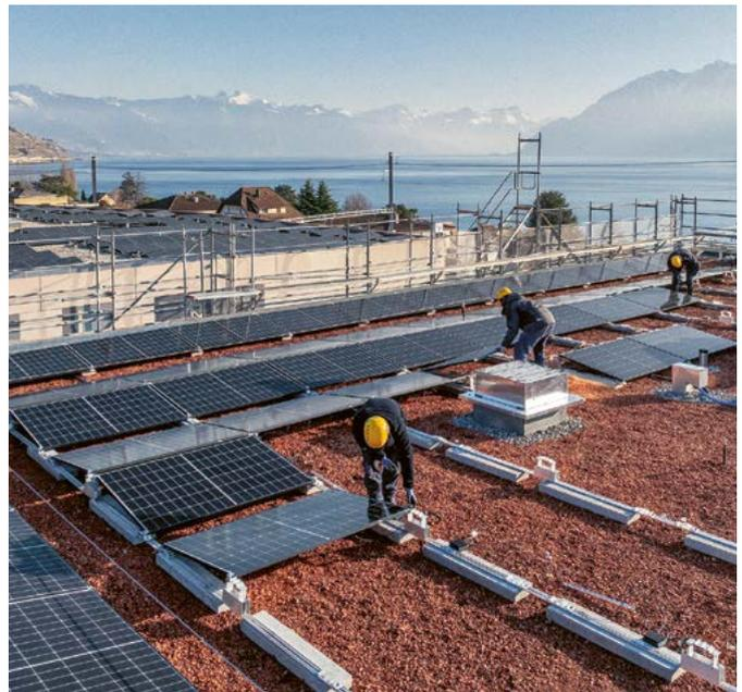
Quelque 440 modules photovoltaïques ont été posés par les collaborateurs d'Agena SA sur les quatre bâtiments du nouveau complexe Cully 360, à Bourg-en-Lavaux. La production d'électricité renouvelable estimée est équivalente à une consommation moyenne annuelle de plus de 40 ménages.
