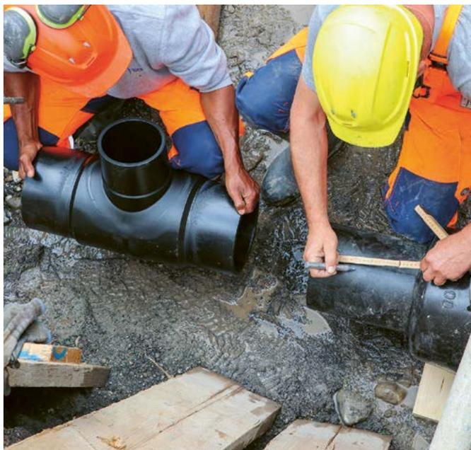
Les équipes en charge des réseaux de gaz assemblent différentes pièces en vue de raccorder les nouvelles conduites menant au poste de détente et de comptage (PDC) de Gaznat SA, à Vevey.
