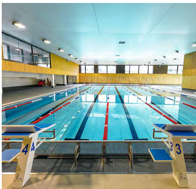
La Piscine intercommunale des Chavannes, à Cossonay, sur le réseau de Cosvegaz SA, a ouvert ses portes en juillet 2021. Elle dispose d'installations chauffées à 100% au biogaz, une énergie renouvelable, locale et neutre en CO 2 , grâce à un partenariat avec Energiapro SA.
