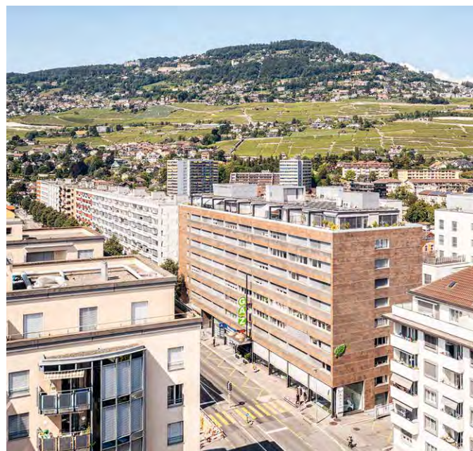
Un projet de rénovation du bâtiment a débuté au siège de HOLDIGAZ SA, à Vevey, durant l'exercice 2021 - 2022. Des travaux conséquents ont été entrepris afin de remplacer les installations de chauffage, qui alimentent le réseau de chauffage à distance du quartier. Cet assainissement a été complété par la pose d'une toiture solaire photovoltaïque produisant de l'électricité renouvelable pour le site.
