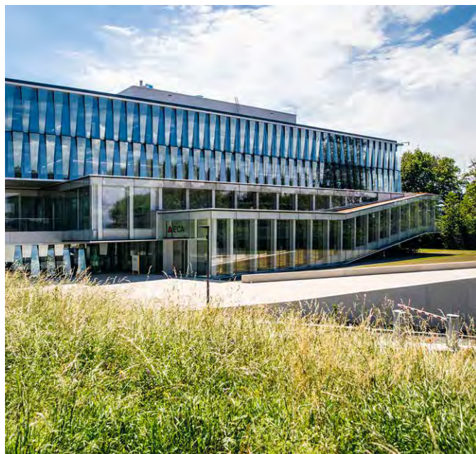
Brauchli SA a réalisé sur deux ans toutes les installations de chauffage et de rafraîchissement du nouveau bâtiment de l'ECA, à Lausanne.
