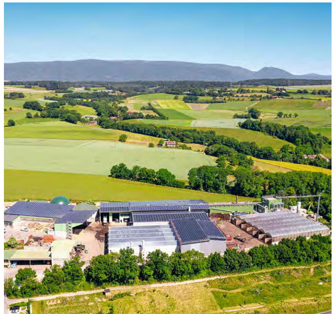
Plusieurs améliorations ont été apportées au site d'Ecorecyclage SA durant l'exercice : la construction d'un digesteur liquide, le développement de nouvelles zones de réception des déchets organiques et la finalisation des toitures solaires photovoltaïques.
