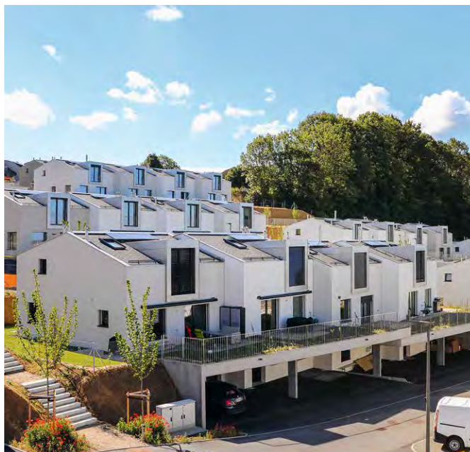
Le nouveau développement Smarthill, à proximité de Lausanne, a bénéficié du savoir-faire de Joseph Diémand SA pour la réalisation des installations sanitaires des villas.
