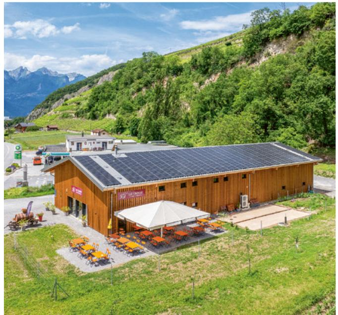
Près de 600 m<sup>2</sup> de modules photovoltaïques ont été posés par Agena SA sur le toit de Badan Vins, à Ollon, dans le cadre d'un contracting solaire d'Energiapro SA. La production d'électricité renouvelable estimée est équivalente à une consommation moyenne annuelle de près de 35 ménages.
