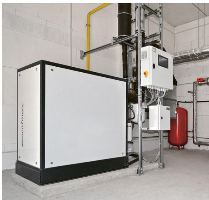
Une installation de couplage chaleur-force produit de l'électricité, qui peut être autoconsommée ou réinjectée dans le réseau. La chaleur issue de cette production est utilisée pour le chauffage et/ou l'eau chaude sanitaire, permettant ainsi de valoriser plus de 100% de l'énergie consommée.
